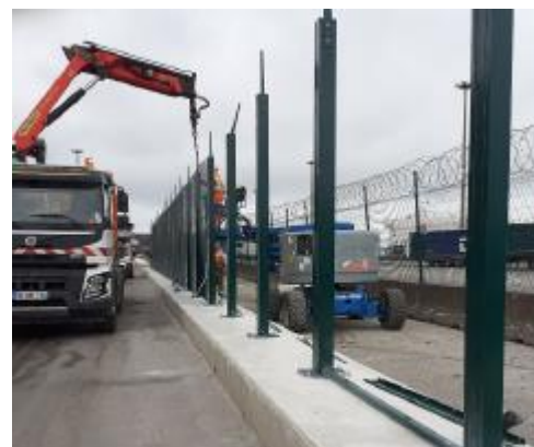
Rénovation du quai de Lorraine et sécurisation du Terminal Irlande
