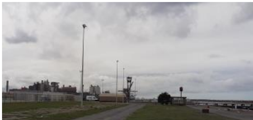
Rénovation de l'éclairage du sas de l'Écluse De Gaulle.
