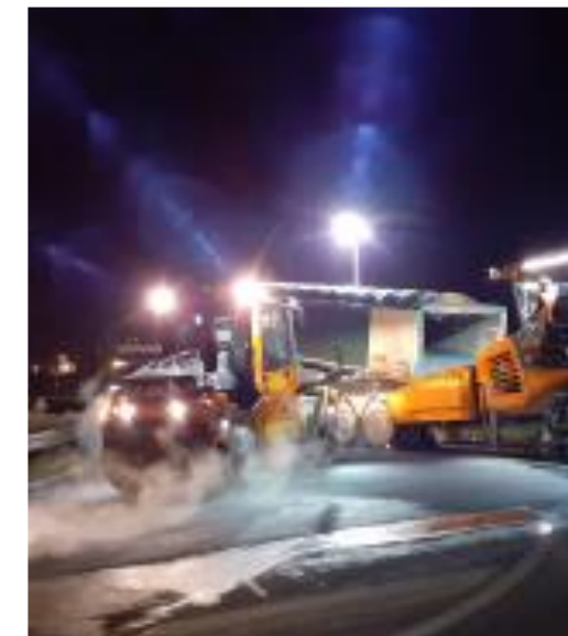
Travaux de réfection des enrobés de la route du Fortelet
