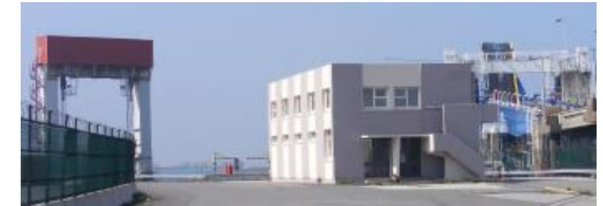
Refonte du poste Haute Tension/Basse Tension Transmanche et sécurisation des équipements et personnes.
