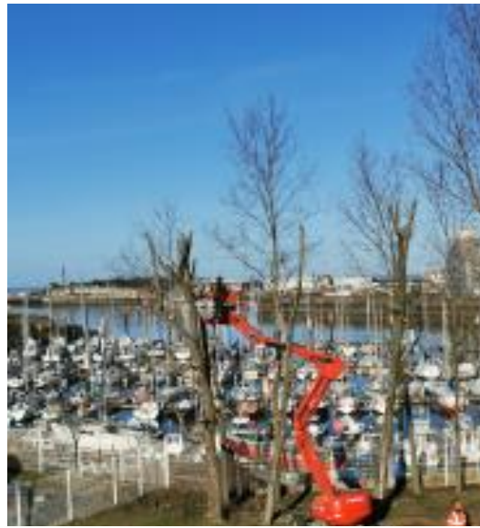
Abattage et élagage des arbres pour sécuriser les abords du bâtiment administratif,
